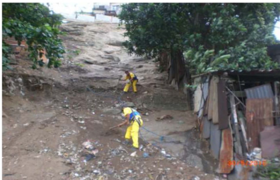
FIGURA 7 – VISÃO FRONTAL DE DESLIZAMENTO QUE EXPÔS O PERFIL DE SOLO. SOLO RESIDUAL NO TOPO EM CONTATO DIRETO COM ROCHA SÃ.
