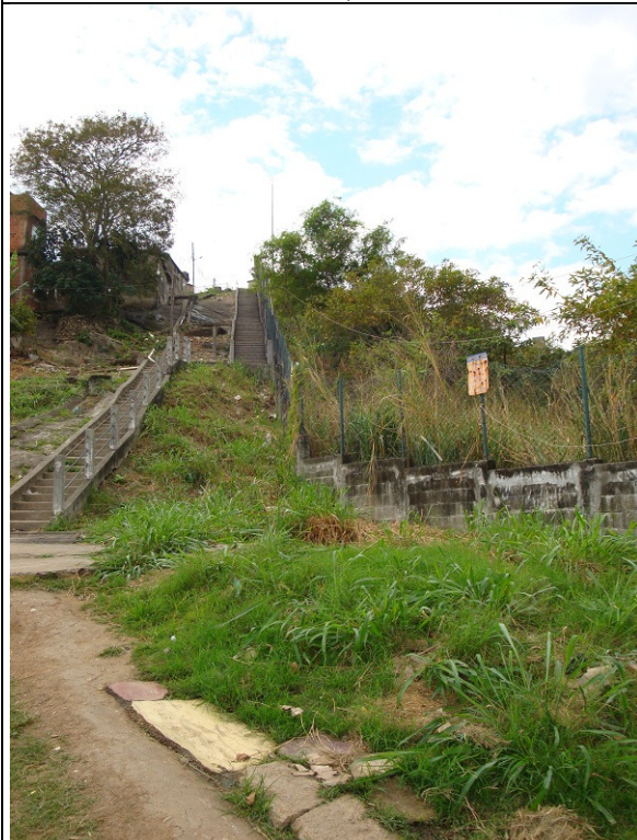
Foto 22 - Muro/Escadaria de acesso ao Cruzeiro
