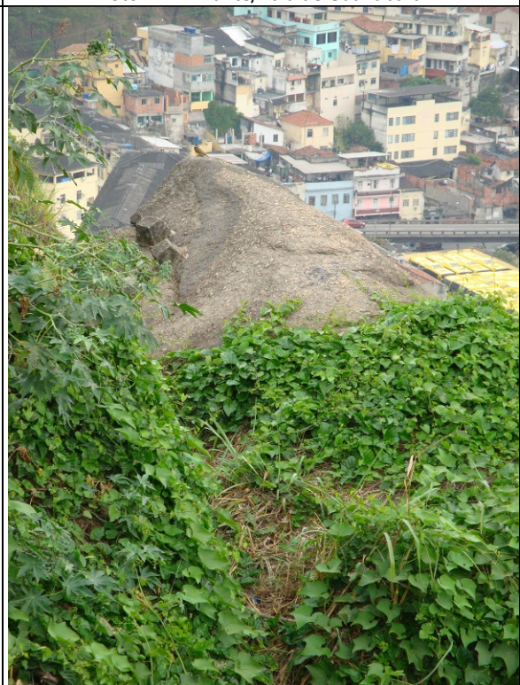
Foto 43 - Exemplo de obra de contenção/Fixação de bloco de rocha – parte alta/escarpa natural
