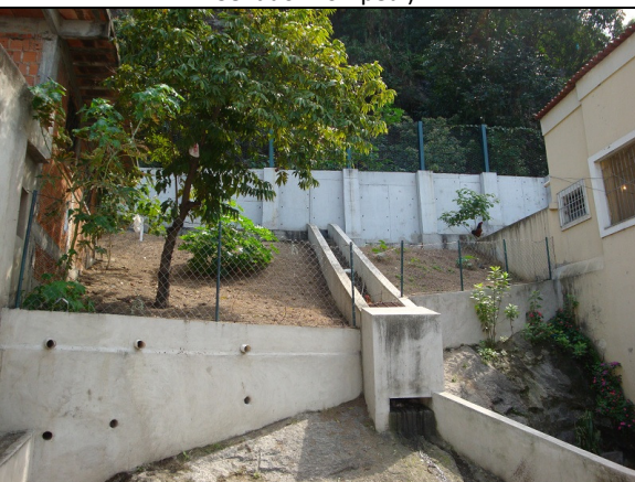
Foto 8 – Muro de contenção/Canaleta (Trav. da Felicidade)
