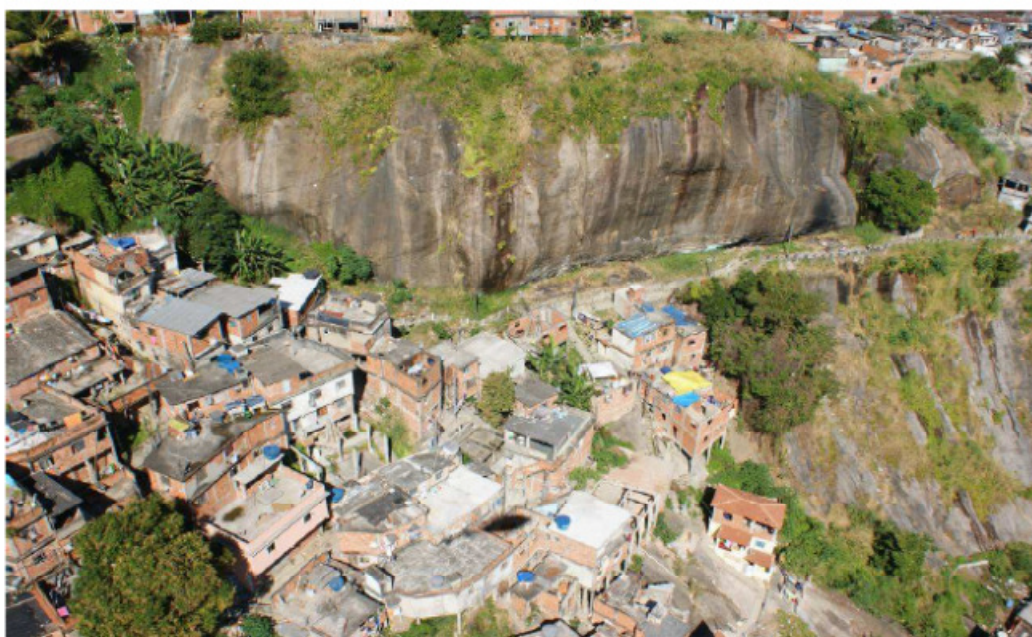
FIGURA 11 - O PRESENTE SETOR LOCALIZADO NA PORÇÃO CENTRAL DA COMUNIDADE TEM SEU RISCO ASSOCIADO A PRESENÇA DE UMA ESCARPA NATURAL.
