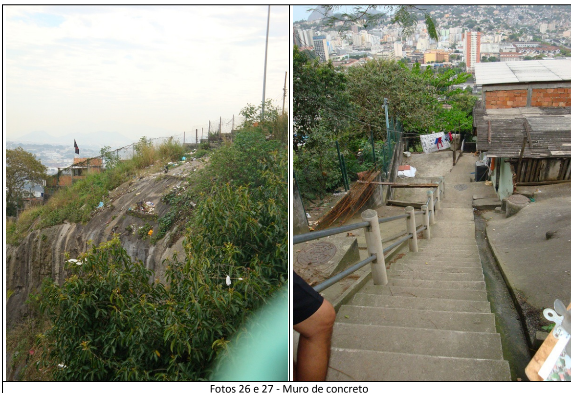
Fotos 26 e 27 - Muro de concreto
