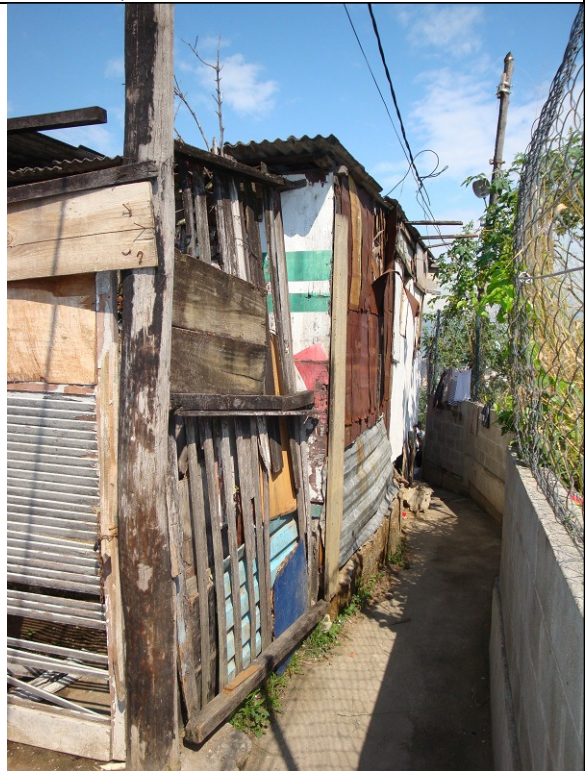
Foto 17 - Muro de concreto e habitação precária/parte alta
