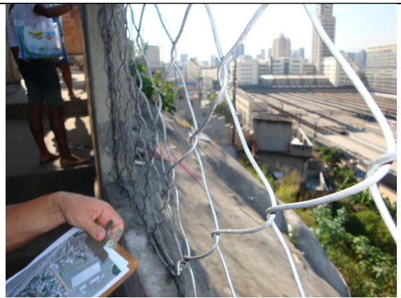
Foto 6 –Obra de contenção (vertente voltada para Rua Senador Pompeu )
