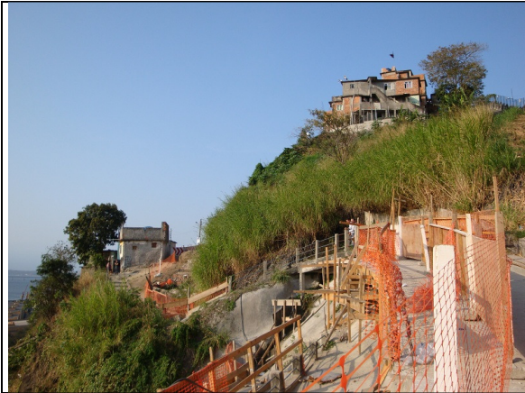
Foto 75 - Rua da Grota/via elevada – visão do “Sessenta” no sentido do Cruzeiro
