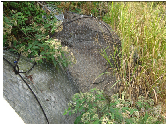
Foto 5 – Tela metálica com chumbadores
