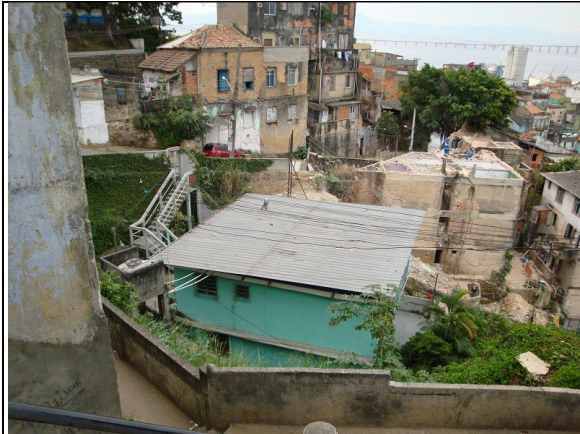
Foto 85 - Ladeira do Faria/Demolição de casas
