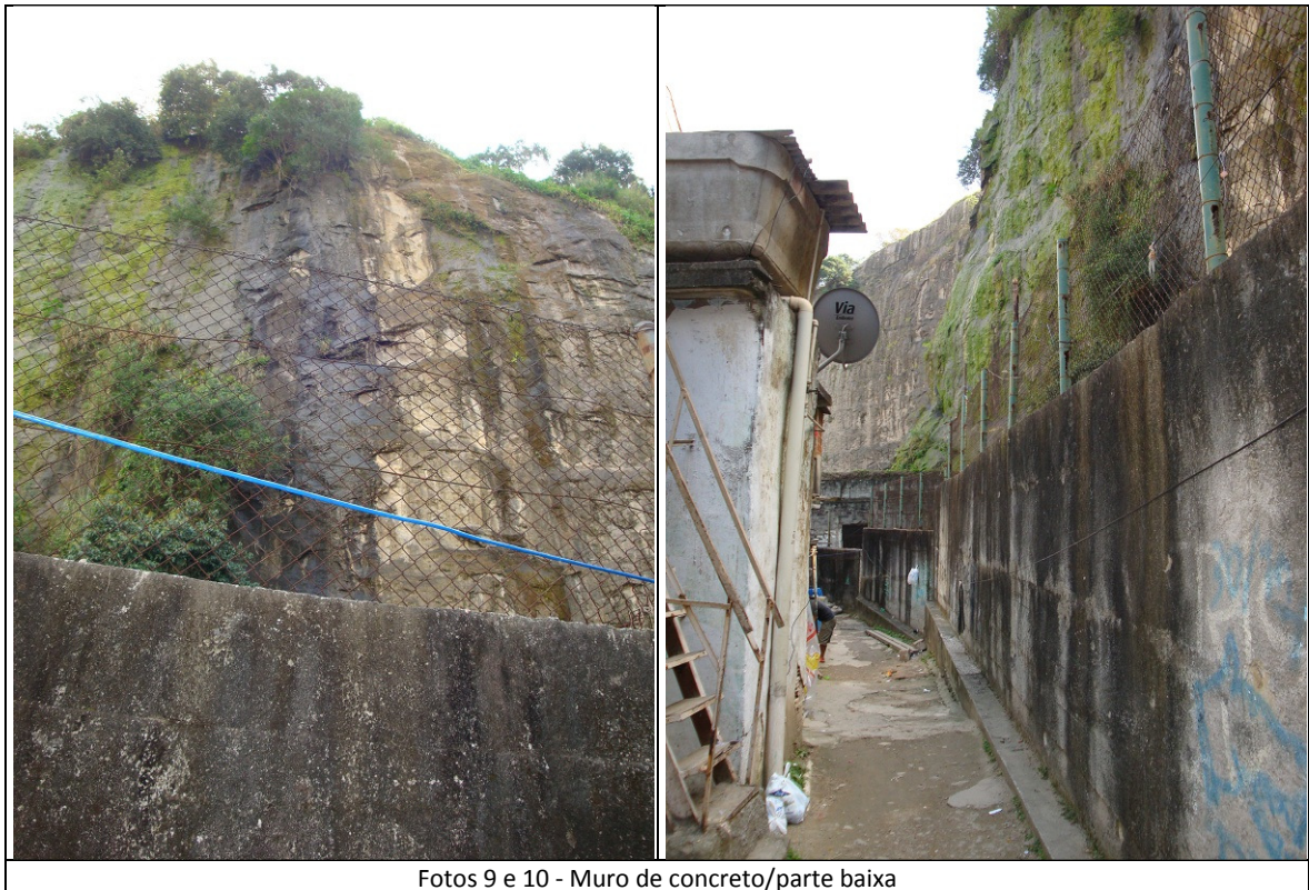
Fotos 9 e 10 - Muro de concreto/parte baixa
