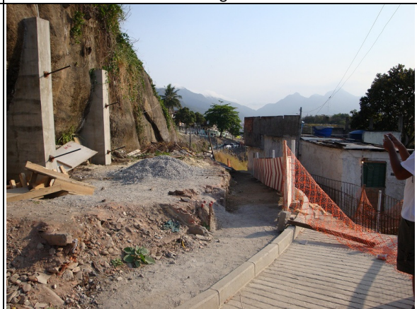
Foto 72 - Rua da Grota/contenção-contrafortes
