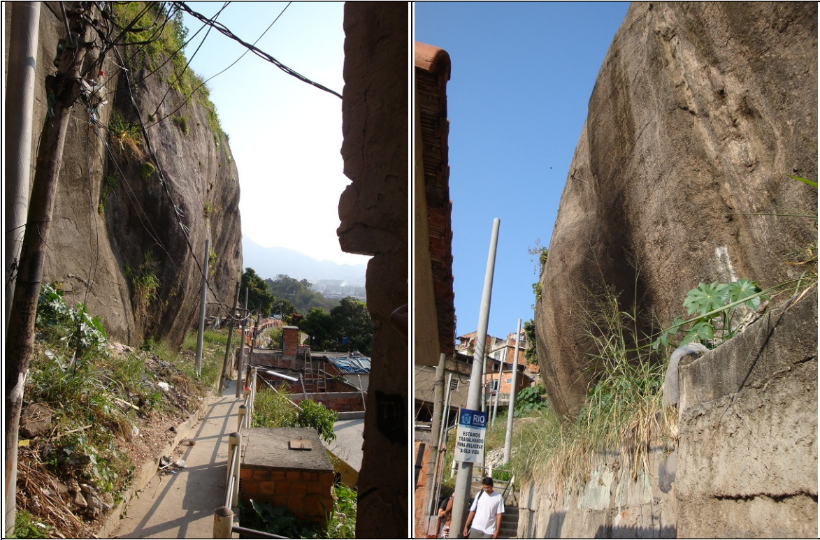
Fotos 65 e 66 - Rua da Grotta/escarpa a montante
